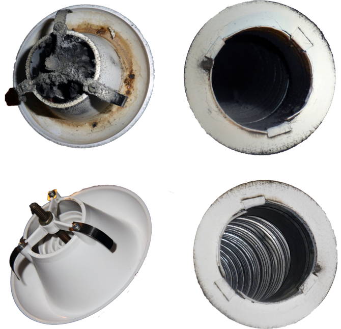
Før- og etter rens av anlegg i privathus.
